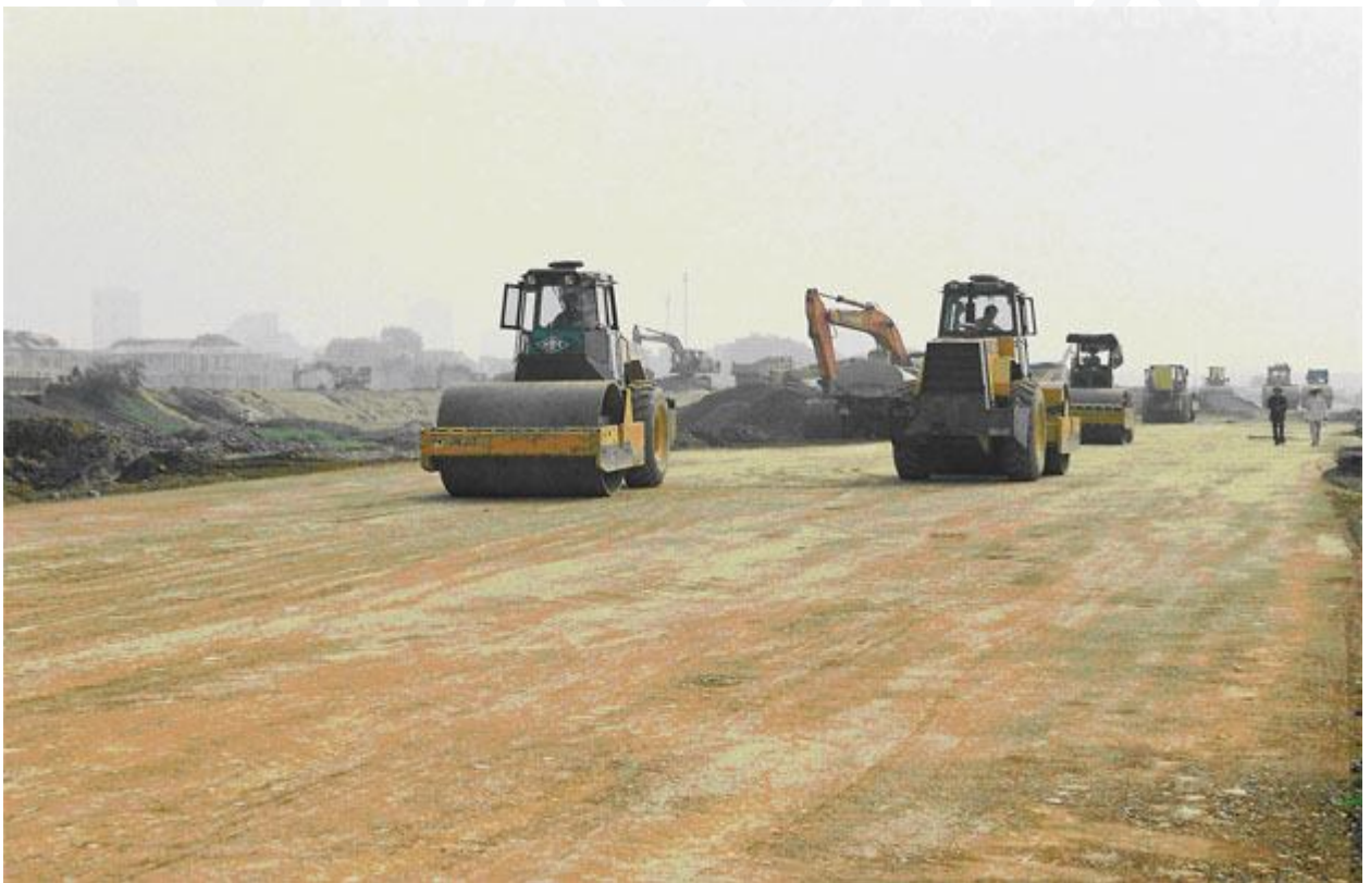
Thi công đường cao tốc Láng – Hòa Lạc
