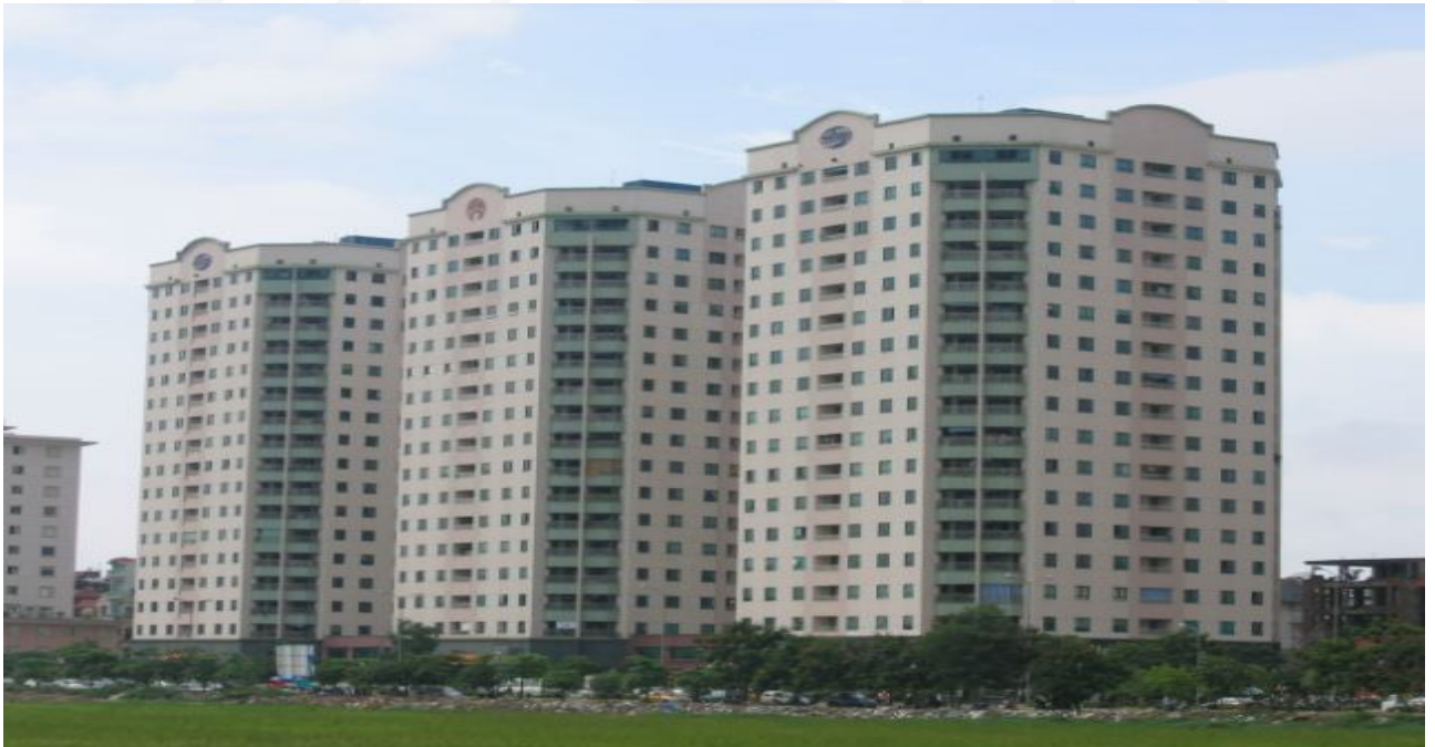
Nhà cao tầng 17T8 Khu đô thị Trung Hòa – Nhân Chính
