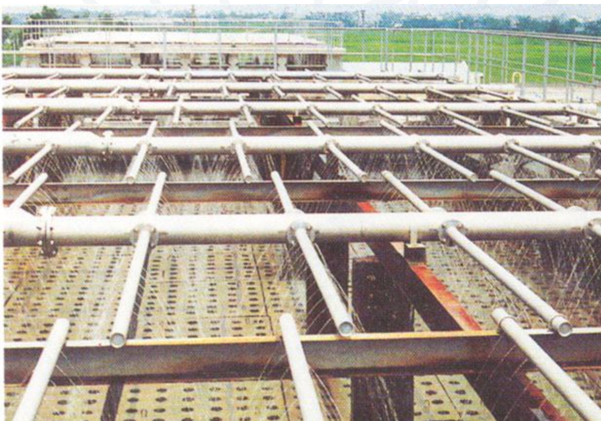
Nhà máy xử lý nước thải khu công nghệ cao Hòa Lạc
