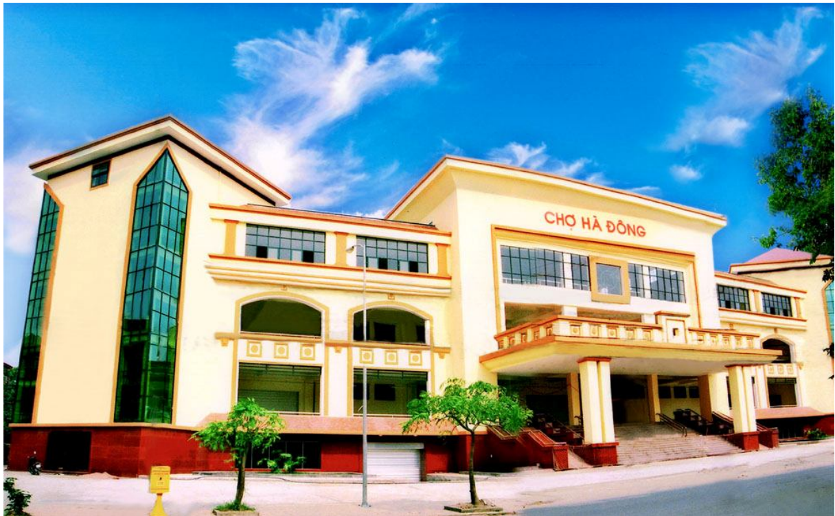
Chợ Hà Đông – Một trong những công trình trọng điểm do Công ty thi công
