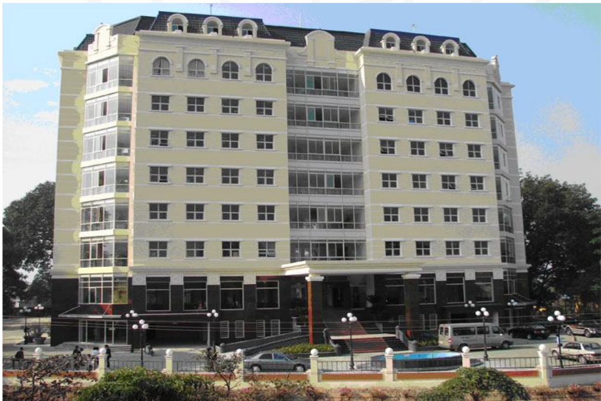
Nhà điều hành than Ưông bí – Công trình do Công ty thi công
